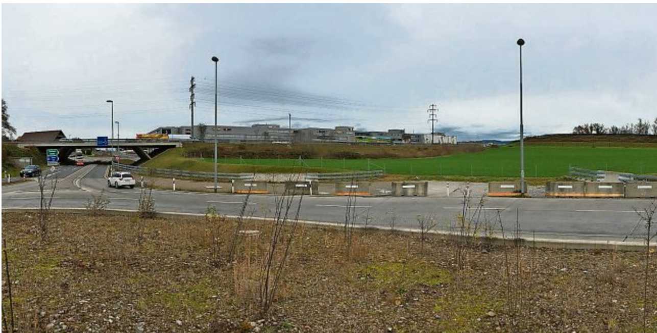
Die derzeit einzige Park+Pool-Anlage im Kanton Zug, beim Autobahnanschluss Lindenham beim südlichen Kreisel, wurde geschlossen und mit Betonelementen abgesperrt.
